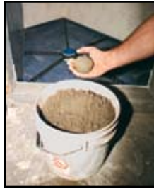
Llénelo con mezcla de cemento y arena
